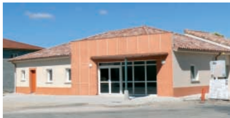
ECLASSAN : construction d'un bâtiment multi-service
