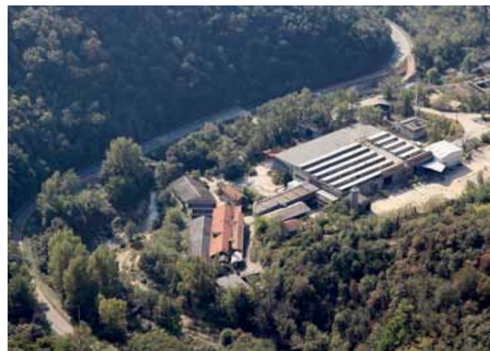
Le site présentera bientôt une vaste plateforme industrielle à aménager.
