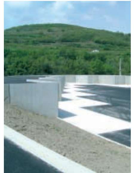
la déchetterie est située sur la nouvelle zone d'activité
